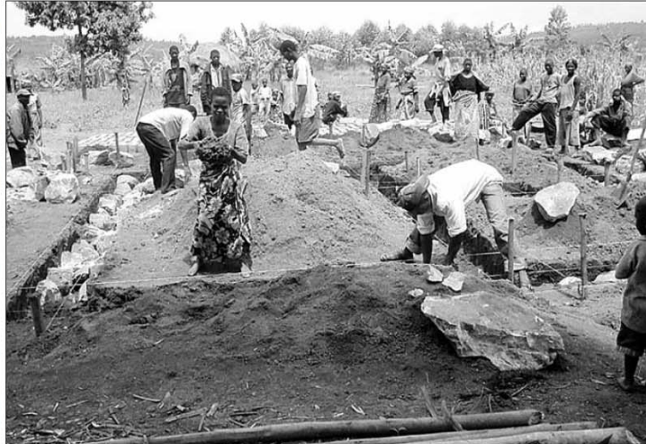
Construyendo los cimientos de las casas del poblado. Fotos: VSF
